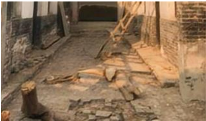
1.松动、破损、丢失、塌陷
