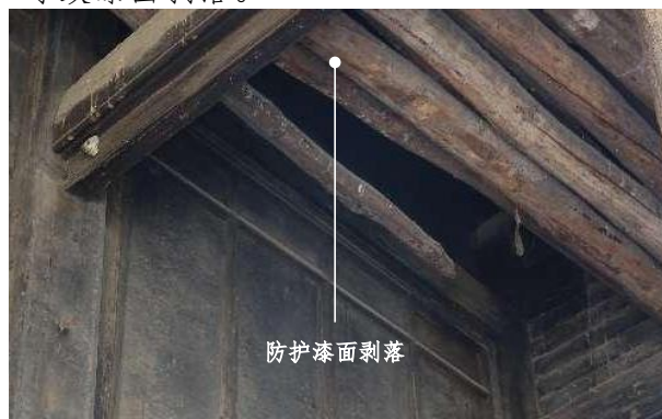
木柱油漆剥落
