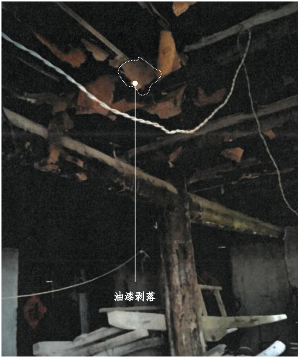
梁架油漆剥落
