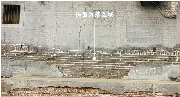
砖墙表面剥落
