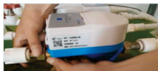
3、安装水表于管道上
