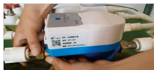
3、安装水表于管道上
