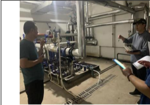
在榆阳区社保局开展实地调研及访谈，了解单位供热现状、供热设施管理及运维状况。
